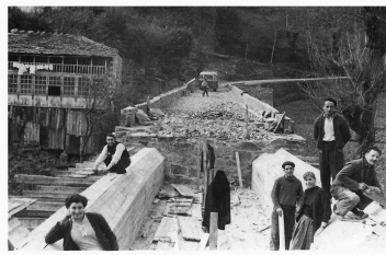
Construción da ponte nova de Navia.
