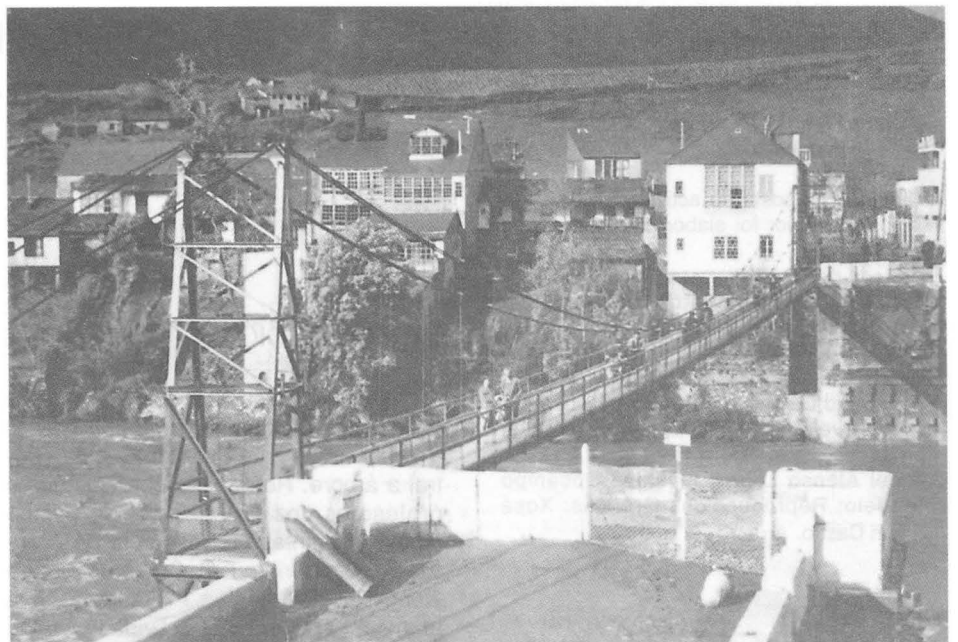
Pasarela colgante construída en marzo/abril de 1960 por "Dragados y Construcciones"
